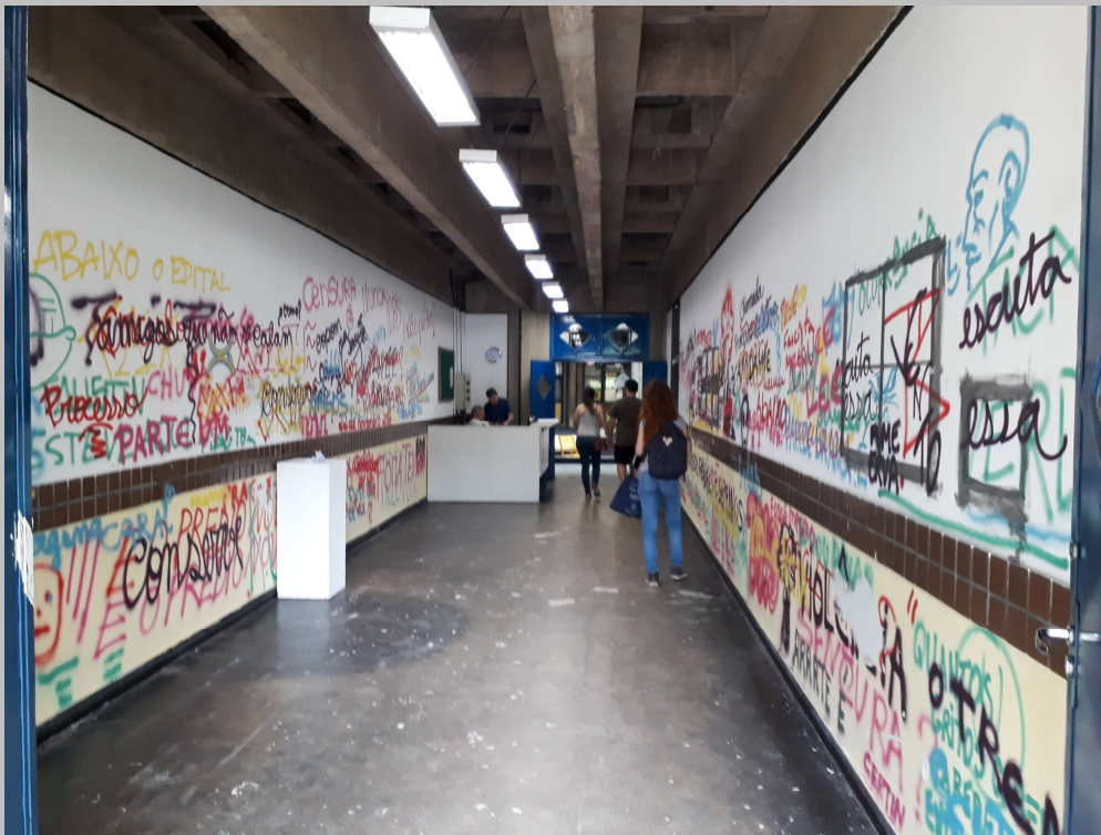
Condições do corredor pichado antes da montagem e aplicação da pintura
